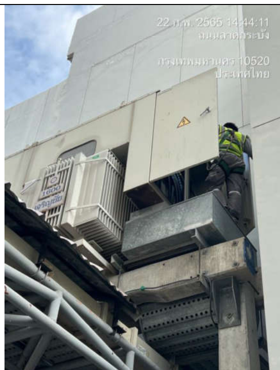
Photo 1-2-3-4-5-6: ภาพของการทำความสะอาดและทดสอบ Load Break Switch
