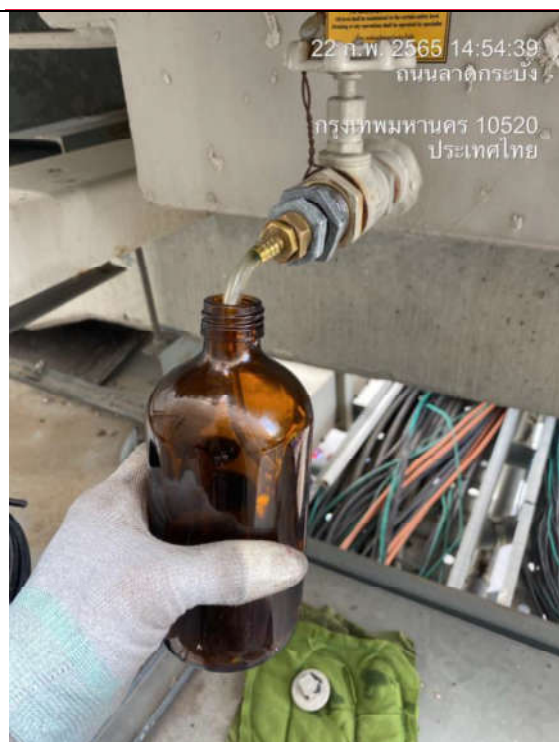
Photo 7-8-9-10-11-12: ภาพแสดงการตรวจสอบและทำความสะอาดของหม้อแปลง, การทดสอบ Insulation Resistance ของหม้อแปลงขณะทำ Preventive Maintenance
