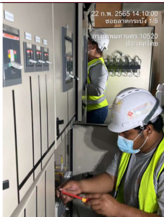
Photo 17-18-19-20-21-22-23-24-25-26 : ภาพแสดงการทำ Preventive Maintenance ตู้ LV MDB, Cap. Bank, Plug-in unit, DB Panel โดยการ Inspection, Cleaning, Tightening torque
