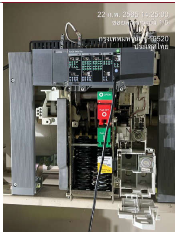
Photo 13-14-15-16: ภาพแสดงการทำความสะอาดและทำการทดสอบ Trip unit, Contact Resistance ของ Air Circuit Breaker
